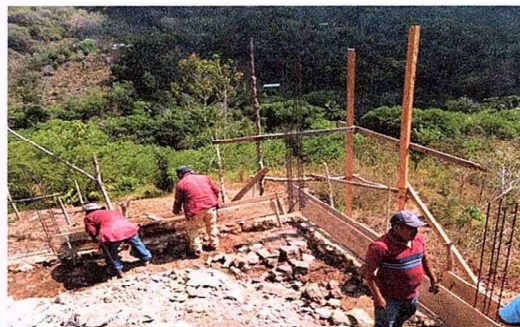
TRABAJO DE MURO DE CONTENSION A UNA PROFUNDIDAD DE 5 METROS APROXIMADAMENTE
