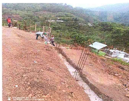
SE PUEDE OBSERVAR EL TRABAJO DE DOS METROS DE PROFUNDIDAD EN LA PARTE MENOS PELIGROSA
